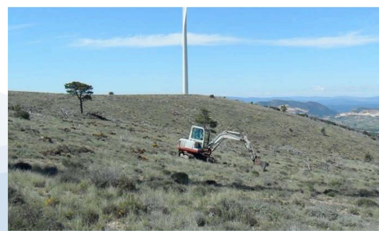
Preparación del terreno con retroexcavadora de cadenas hasta una profundidad de 60 cm, de forma troncopiramidal con 60x60 cm en la parte superior y 40x40 cm en la base. Fotografía: Fondo fotográfico del Servicio de Vida Silvestre.
